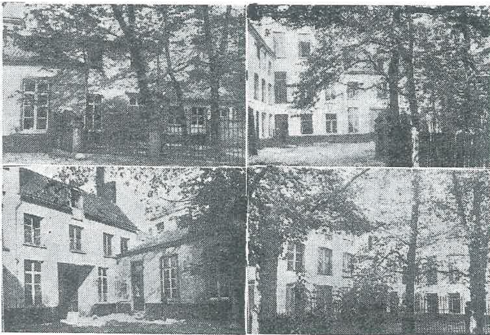
Ce cercle, fondé en 1819, vit s'élever sur son emplacement, rue des Tanneurs, la Caisse Hypothécaire Anversoise
